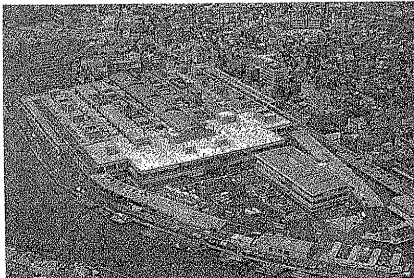
西日本の流通拠点、大阪本場
